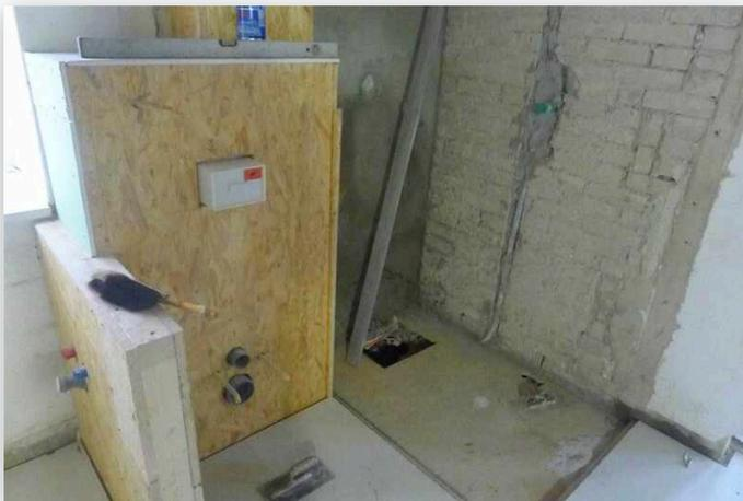
So ganz langsam erkennt man, dass daraus mal ein Bad wird. Fußboden komplett neu aufgebaut, Decke komplett neu aufgebaut. (Später) hinter Glas unsere Walk in Dusche mit Raindance und kalter Schwallbrause, davor Toilette und Waschtisch.
