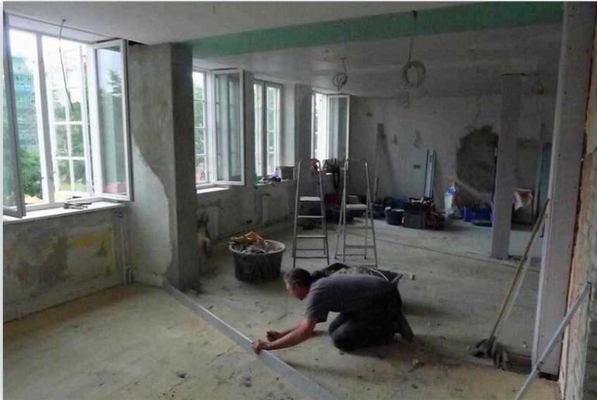
Wir werden doch einiges an Ausgleich benötigen, damit der Boden schön gerade wird. Es ist eben ein altes Haus. Im Erdgeschoß erhalten wir natürlich den schönen Steinboden. Der sieht fast genauso aus wie in der Engelsgrube.
