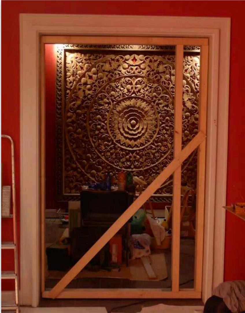
Die Tür zur Fußmassage nimmt Gestalt an. Sie ist mit einem überraschenden Schwingmechanismus ausgestattet, so dass sie geöffnet einen Sichtschutz zu unserem Wartebereich bildet. Idee, Entwurf und Ausführung von tijmdesign, Haarlem.
